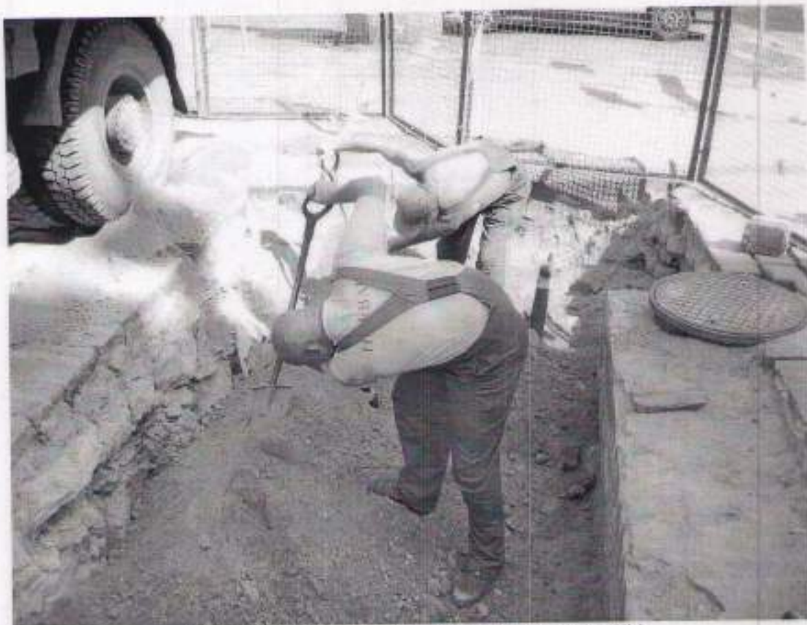
Rys. 9. Zasypywanie wykopu warstwą pospółki
