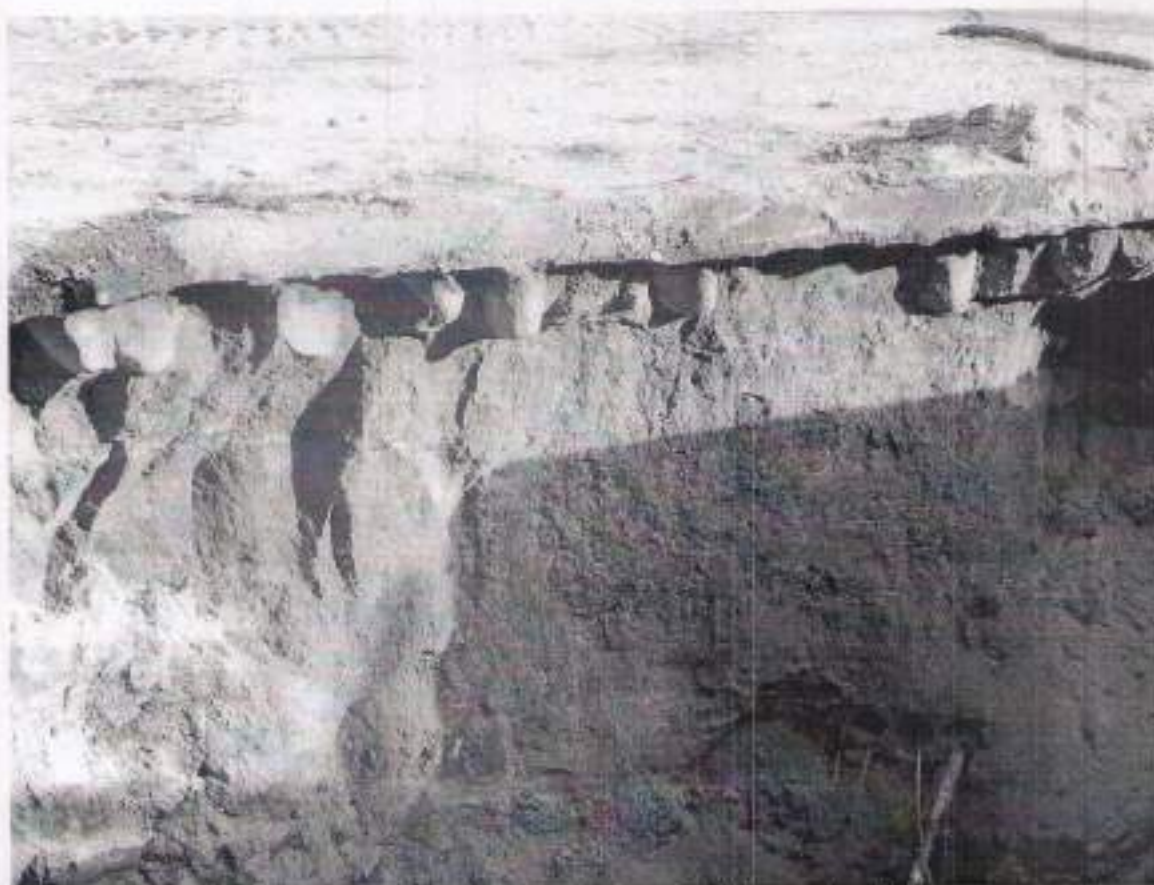
Rys. 4. Przekrój jezdni po wykonaniu prac rozbiórkowych. Widoczne warstwy jezdne asfaltowe, podbudowa z kostki kamiennej oraz podłoże
