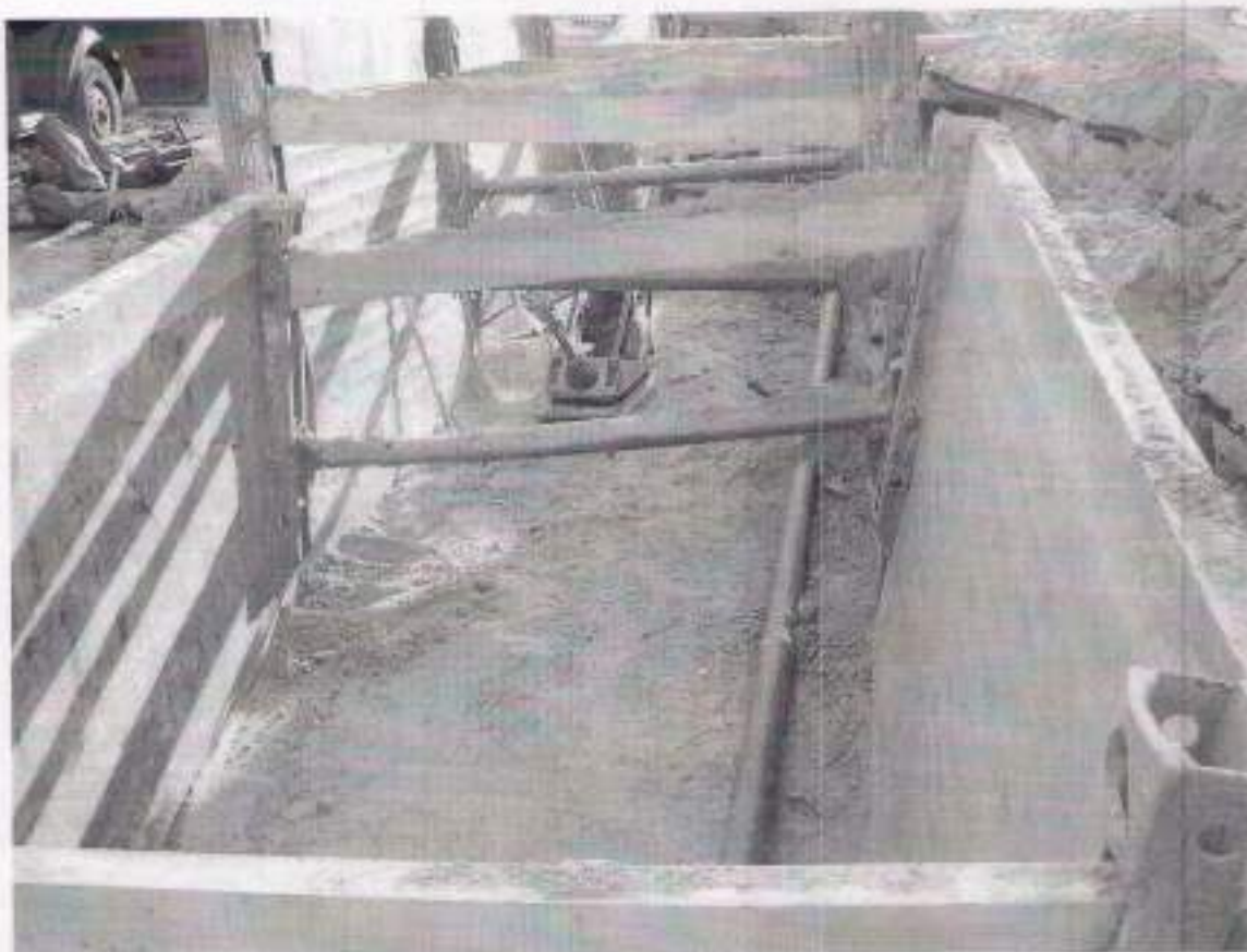
Rys. 3. Warstwa zasypki z piasku
