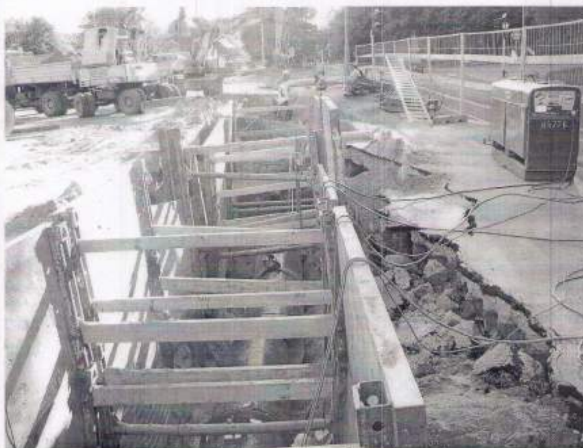
Rys. 2. Degradacja nawierzchni w pobliżu wykopu
