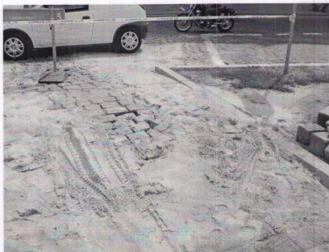
Rys. 8. Przykład zapadnięcia nawierzchni z kostki kamiennej w wyniku awarii sieci wodociągowej
