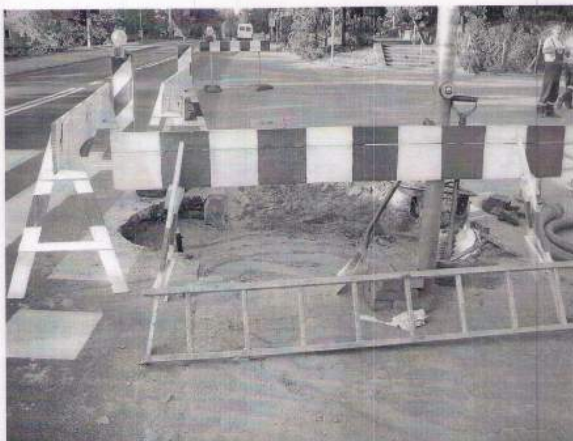
Rys. 7. Przykład wykopu o małej powierzchni (około 4 m 2 ) w obrębie chodnika
