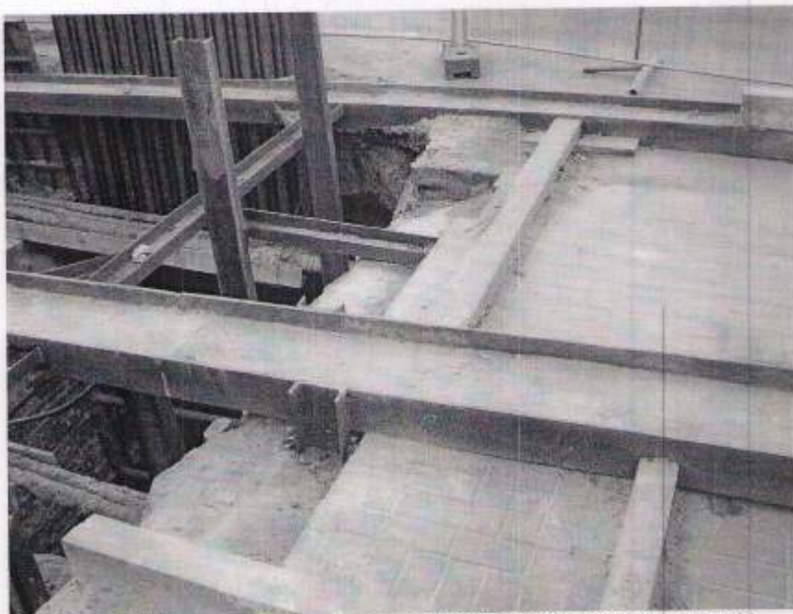
Rys. 10. Wykop w obrębie miejsca postojowego oraz chodnika z kostki betonowej
