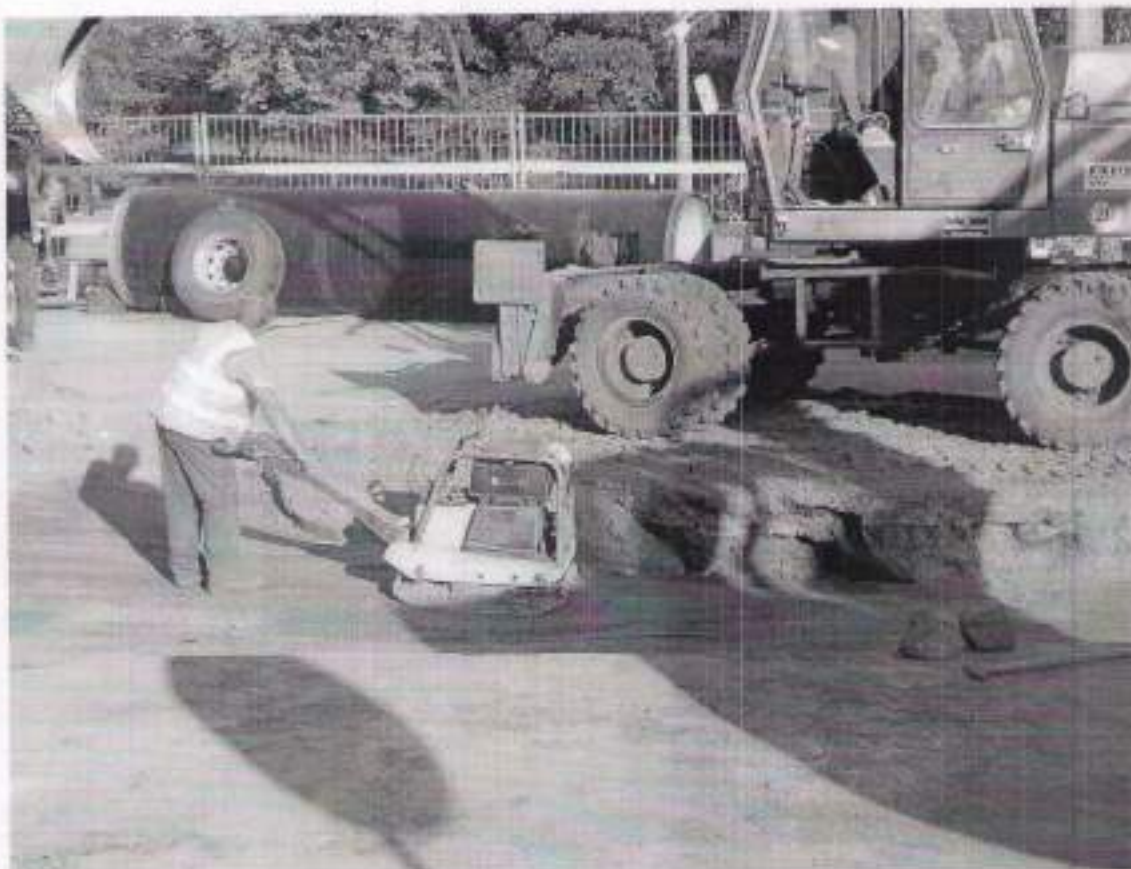
Rys. 5. Zagęszczanie podłoża pod nawierzchnią podczas wykonywania robót odtworzeniowych
